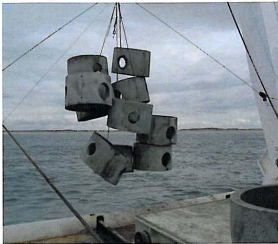
Figure 2. *Assemblage de 10 buses avant mouillage.*
