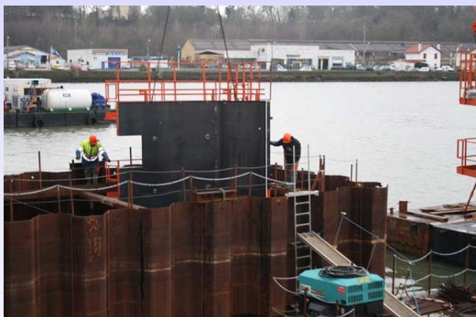
Mise en place du coffrage pour l'élévation de la pile P7
