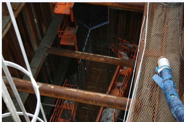
Coffrage en place dans le batardeau P7 autour des cages d'armatures
