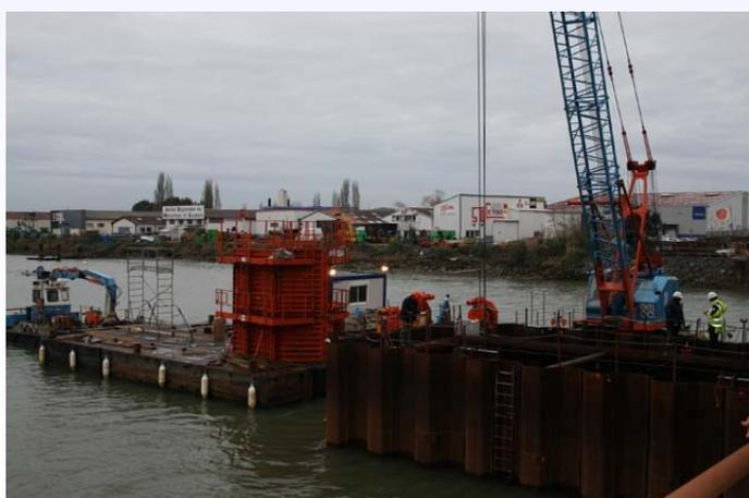
Opération de levage/coffrage sur la pile P7
