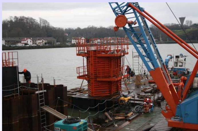
Coffrage sur le ponton en attente de la mise en place dans le batardeau
