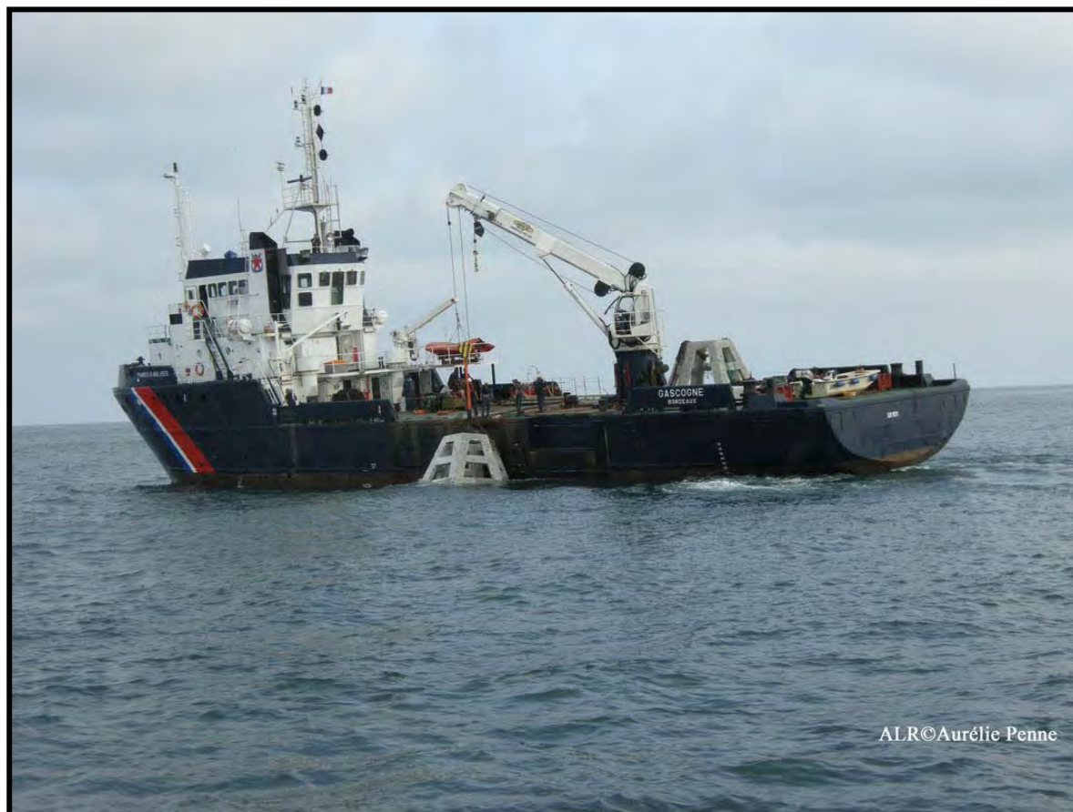
Figure 21 : Immersion du récif Typi avec le Baliseur Gascogne, 29 juin 2010
