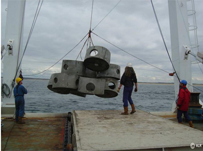
**Figure 1 : Immersion des récifs artificiels (ALR©Gérard Fourneau, 1999).**
