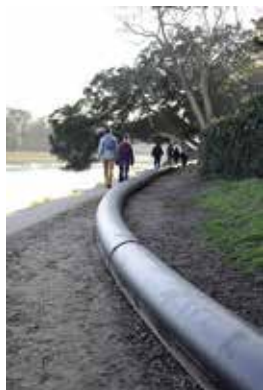
Sur le lac comme sur les berges, le chantier reste pour l'instant en place malgré l'arrêt des travaux.
